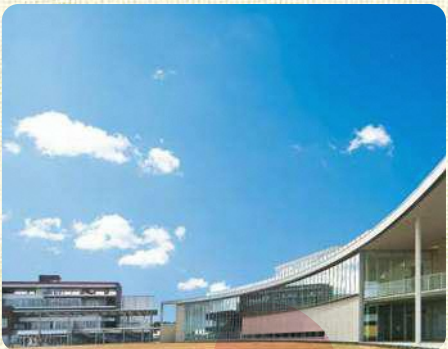
復興への第一歩。地域再生に向けた拠点施設。双葉町産業交流センター/東日本大震災・原子力災害伝承館 (双葉町)
