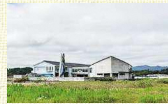
震災遺構 浪江町立請戸小学校
